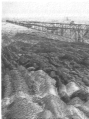
Abraumhalden im Tagebau Welzow-Süd
